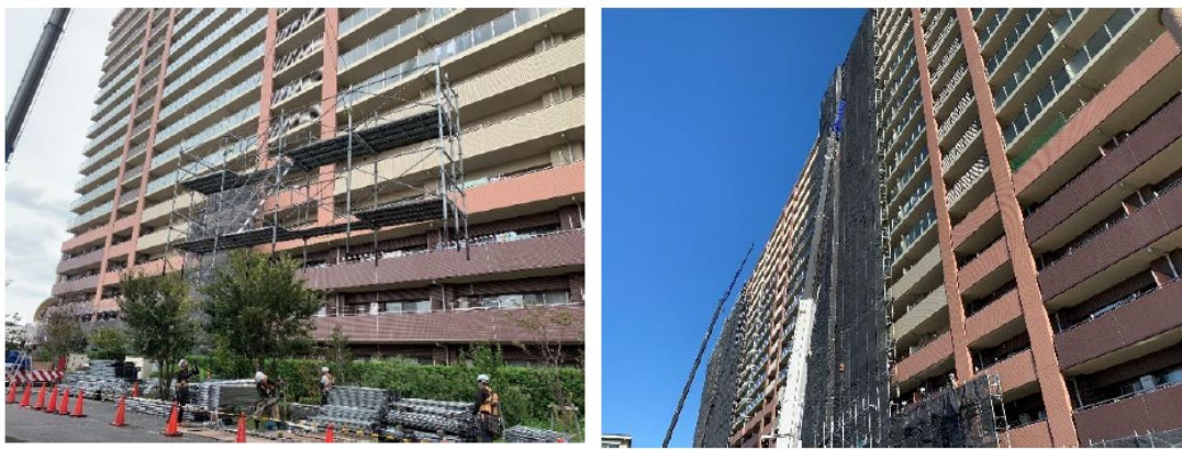
足場大組状況
